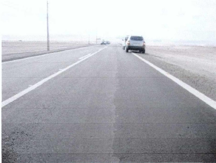
Fallas en la aplicación de la lechada asfáltica
